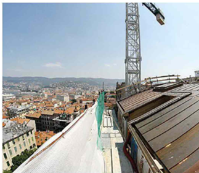
La casa in legno di via Giustinelli
