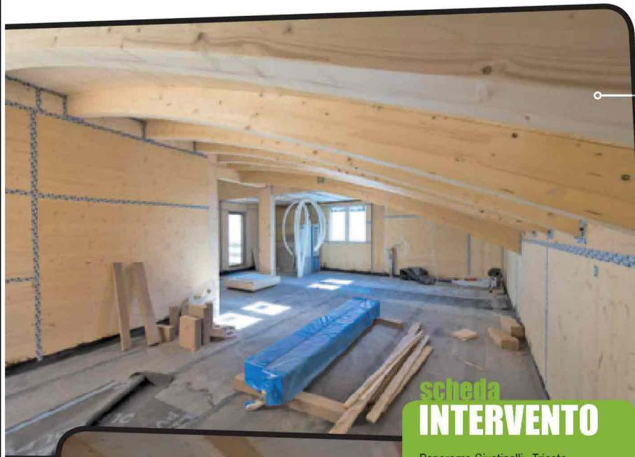
Vista del dettaglio della struttura di legno lamellare in corrispondenza della parte sottostante della copertura
